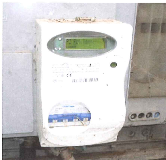
QUADRO ELETTRICO:Q65 VIA RESISTENZA
